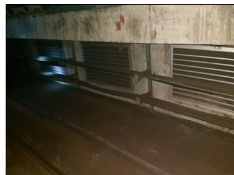
ภาพที่ 2.2-5 แคมเปอร์ระดับราง สำหรับเป็นช่องดูดอากาศออก
